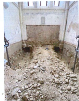
Vue générale des terrassements en fouille des reprises en sous œuvre du chœur
