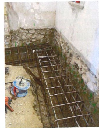
Mise en œuvre des ossatures des reprises en sous œuvre
