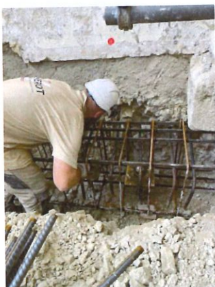
Détail de la mise en œuvre des ossatures des reprises en sous œuvre du chœur
