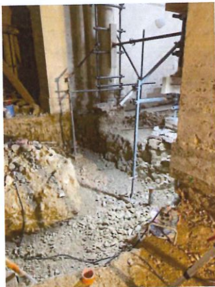
Détail des reprises en sous œuvre de la croisée en cours de terrassement au droit de l'arc triomphal
