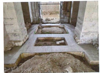
Détail des reprises en sous œuvre achevées au droit de la croisée
