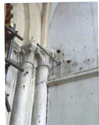
Détail de la tête du tirant du Bras Nord du Transept ouvrant sur le chœur
